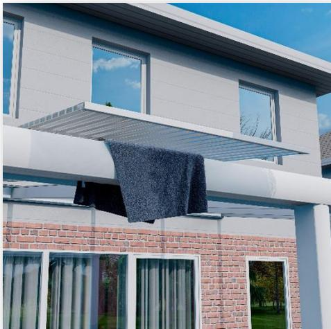
Tipp: Wenn Sie die Überdachung mit Stegplatten oder VSG Glas eindecken, empfiehlt es sich, an der Vorderseite des Rinnenprofils einen weichen Stoff aufzulegen. Dadurch vermeiden Sie Kratzer, die während der Montage entstehen können.
