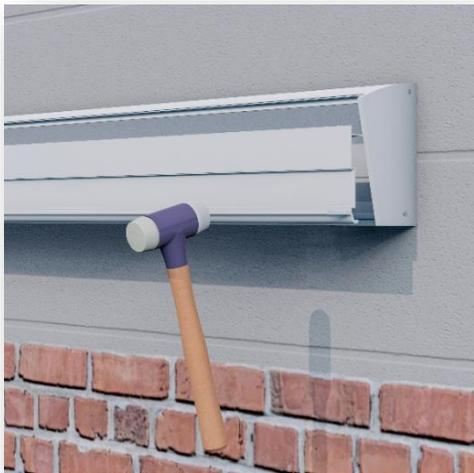
Als nächstes bringen Sie die Scharniere an das Wandprofil an. Platzieren Sie die obere Seite der Scharniere möglichst nah an der Wand, um den optimalen Winkel zu erreichen. Mit einem Gummihammer ist dies sehr einfach anzubringen.
