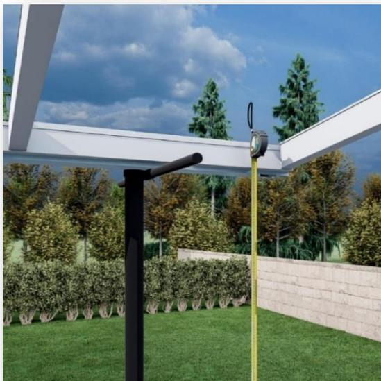
Nach der Vormontage der Konstruktion über Kopf sind als nächstes die vorderen Pfosten an der Reihe. Messen Sie bitte die Höhe vom Boden bis zum unteren Rand der Rinne, an der der Pfosten positioniert wird. Beachten Sie, dass das System über ein Scharnier-System verfügt, das eine Dachneigung von 3-18 Grad ermöglicht. Dadurch können Sie die Höhe der vorderen Pfosten in diesem Schritt bequem wählen.
