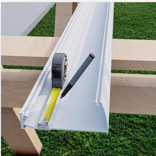
Im nächsten Schritt bereiten Sie das Wandprofil vor, da es wichtig ist, dass die Terrassenüberdachung sicher und stabil montiert wird. Beginnen Sie, indem Sie an einer verstärkten Stelle eine Markierung vornehmen. Die erste Markierung sollte ungefähr 10 cm von außen erfolgen, danach zeichnen Sie alle 50 bis 80 Zentimeter die Bohrpunkte. Die gewählte Distanz hängt von der Tiefe und der Art der Eindeckung ab. Im Zweifelsfall empfehlen wir einen Abstand von 50cm.
