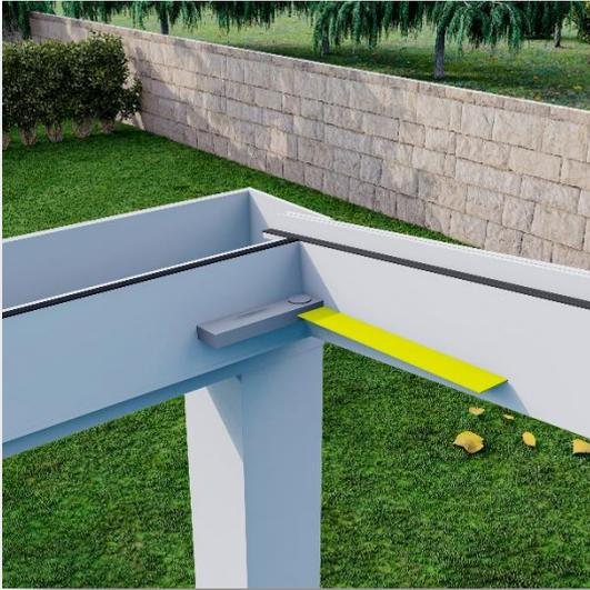
Nachdem alle Pfosten angebracht und mit der Rinne verschraubt wurden, richten Sie die Rinne in Richtung des Wandprofils aus. Verwenden Sie dazu einen 90-Grad-Winkel an der Rinne zum Träger bzw. am Wandprofil zum Träger. Um einen 90-Grad-Winkel zu erreichen können Sie die Rinne etwas anheben und nach rechts bzw. links schieben.
