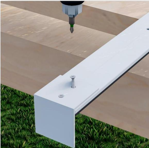
Die Innen- und Außenklipse erhalten an einer Seite einen L-förmigen Winkel. Dieser Winkel dient als Stopper für die Eindeckung, damit sie nicht in Richtung der Rinne durchrutschen kann. Befestigen Sie mittig diese mit ein oder zwei Schrauben.
