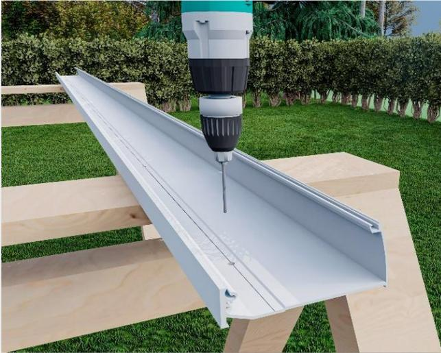
Bohren Sie dann an den markierten Stellen die Löcher. Die erforderliche Stärke hängt von dem verwendeten Befestigungssystem ab, in den meisten Fällen beträgt sie 10mm.
