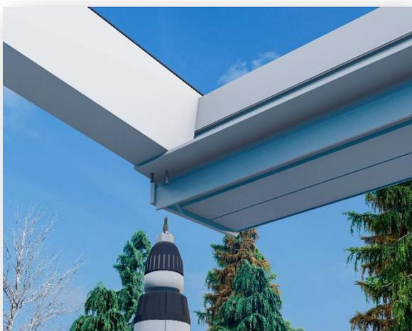
Befestigen Sie jedes Profil unterhalb des Wandprofils und des Rinnenprofils mit je zwei Schrauben. Da die Aluminiumlegierung sehr stark ist, empfiehlt es sich, vorzubohren. Vorbohren mit: 3,2mm
