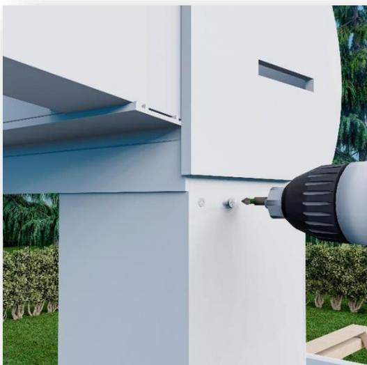
Bringen Sie nun die Pfosten unterhalb der Rinne an und befestigen Sie die Pfosten Seitlich mit zwei je 2 Schrauben am inneren U-Profil.
