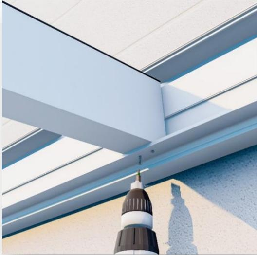
Nachdem die Konstruktion im rechten Winkel steht, können nun alle noch lose hängenden Träger befestigt werden. Wie auch bei den seitlichen Trägern vorgesehen, sollten an der Rinnen- und Hausprofileseite unterhalb der Scharniere jeweils mit zwei Schrauben befestigt werden.
