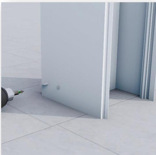
Verschrauben Sie nun die Pfosten seitlich mit zwei je 2 Schrauben am inneren U-Profil.
