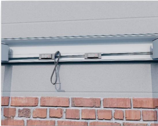
Falls Sie LED-Beleuchtungen bestellt haben, sind diese bereits in die Träger vormontiert und die Kabel befinden sich auf einer Seite. Sie können die Kabel bequem entlang des Wandprofils verlegen. Auch der Transformator sollte an dieser Stelle versteckt montiert werden. Sobald der Abstandhalter/Blende montiert ist, befindet sich alles im nicht sichtbaren Bereich.
