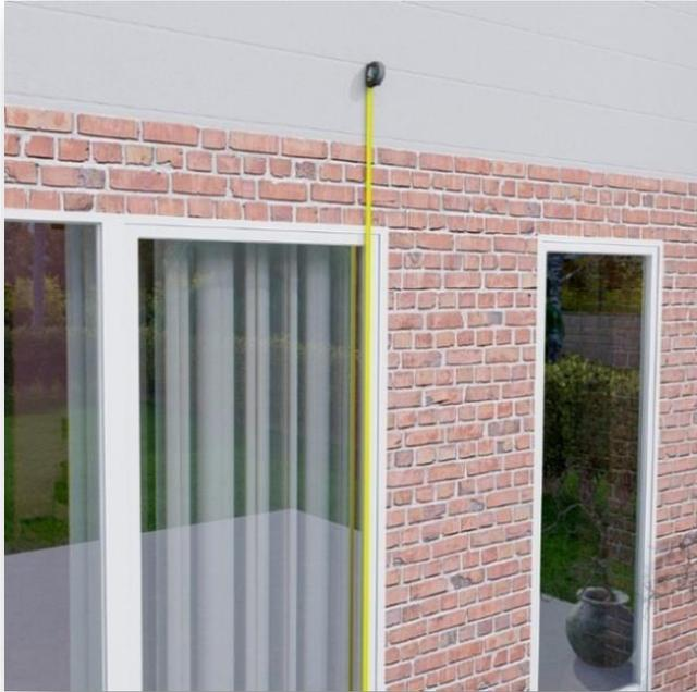
Installieren Sie das Wandprofil an der Außenwand Ihres Hauses, empfohlen wird dabei die Höhe der Zwischendecke (wenn möglich). Hier wird in den meisten Fällen die beste Stabilität erreicht.
