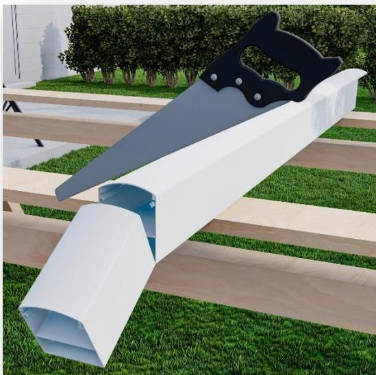
Die Pfosten haben eine Überlänge von ca. 2,5 m. Bitte schneiden Sie den Pfosten auf die zuvor gemessene Länge. Für einen sauberen Schnitt empfiehlt sich die Verwendung einer Kappsäge.
