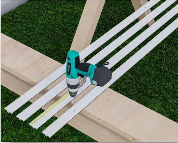
Markieren und Bohren Sie vor der Verschraubung am Träger die Innen- und Außenliegende Klipse vor. Dadurch wird sichergestellt, dass die Schrauben nach der Montage oberhalb der Überdachung in einer Flucht liegen. Die erste und letzte Bohrung sollten Sie jeweils 20 cm vom Profilende entfernt vornehmen. Die Abstände zwischen den Innenbohrungen sollten zwischen 80 und 120 cm liegen. Vorbohren mit: 3,5mm
