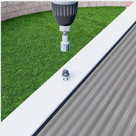
Nun können Sie Ihre Eindeckung auf der Konstruktion installieren. Beginnen Sie dabei an einer Seite, beispielsweise von rechts nach links, um einfacher an die Klipse zu gelangen. Belegen Sie immer ein Feld, befestigen Sie den Klipp, dann das nächste Feld und dann wieder einen Mittelklipp.
