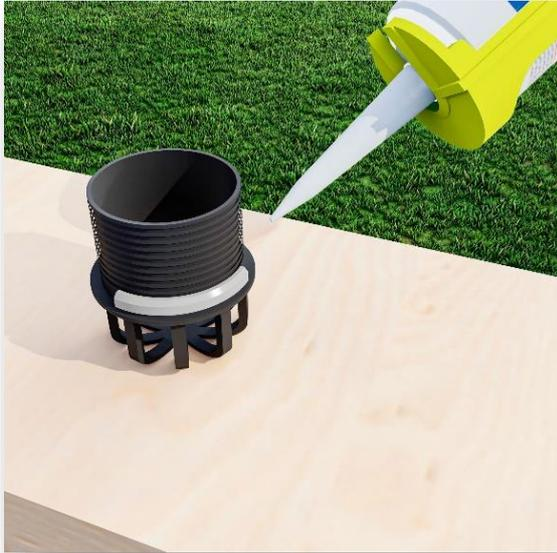
Es wird empfohlen, im Innenbereich, wie auf dem Bild dargestellt, Silikon einzuziehen, bevor Sie den Schraubstutzen für das Fallrohr befestigen.
