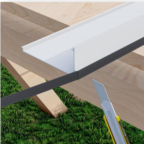
Befestigen Sie die Gummierung am Abstandhalter. Dieses Gummi ist dasselbe wie auf dem Träger! Die Gummis sollten bündig abschließen.
