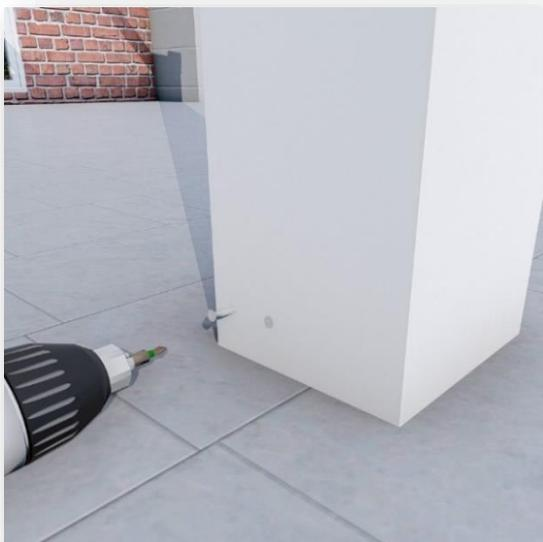
Sobald alle U-Profile für die Pfosten am Fundament verankert wurden, können Sie die Konstruktion sanft anheben, sodass die Pfosten über den U-Profilen positioniert sind. Anschließend wird das System behutsam wieder ablegt, um sicherzustellen, dass die U-Profile innerhalb der Pfosten liegen. Nun werden die Pfosten auf beiden Seiten jeweils mit zwei Schrauben befestigt. Auch hier ist es ratsam, eine Vorbohrung in 3,2mm zu machen.
