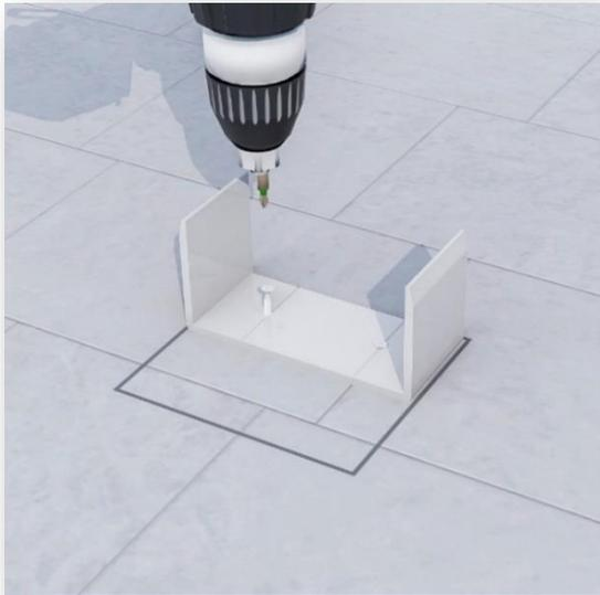
Sobald die Konstruktion und die Pfosten im richtigen Winkel zueinander stehen, Zeichnen Sie den Umriss des Pfostens. Anschließend können Sie das gesamte System einschließlich der Pfosten vorsichtig zur Seite schieben, um den U-Profil am Boden innerhalb des Umrisses sicher zu verankern. Beachten Sie dabei, dass das U-Profil idealerweise weit hinten innerhalb des Umrisses angebracht wird.
