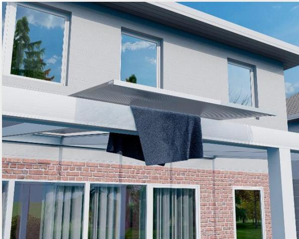
Tipp: Wenn Sie die Überdachung mit Stegplatten oder VSG Glas eindecken, empfiehlt es sich, an der Vorderseite des Rinnenprofils einen weichen Stoff aufzulegen. Dadurch vermeiden Sie Kratzer, die während der Montage entstehen können.
