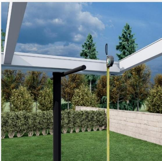
Nachdem die Konstruktion über Kopf vormontiert ist, sind als nächstes die vorderen Pfosten an der Reihe. Bitte messen Sie die vorhandene Höhe vom Boden bis zum unteren Rand der Rinne, an der der Pfosten anschließend platziert wird.
