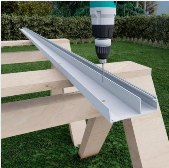
Bohren Sie dann an den markierten Stellen Die Löcher. Die erforderliche Stärke hängt von dem verwendeten Befestigungssystem ab, in den meisten Fällen beträgt sie 10mm.
