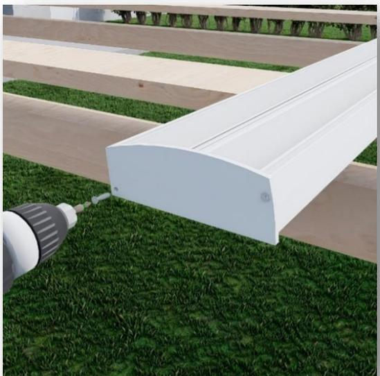
Befestigen Sie zum Schluss die seitlichen Abdeckungen des Profils. Mit dem mitgelieferten schrauben.
