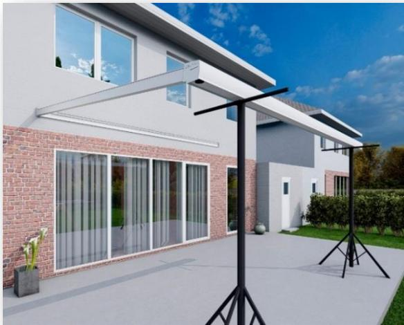
Als nächstes bringen Sie bitte die beiden äußeren Trägerprofile an. Befestigen Sie jedes Profil oberhalb des Wandprofils und des Rinnenprofils mit je zwei Schrauben. Da die Aluminiumlegierung sehr stark ist, empfiehlt es sich, vorzubohren. Vorbohren mit: 3,2mm
