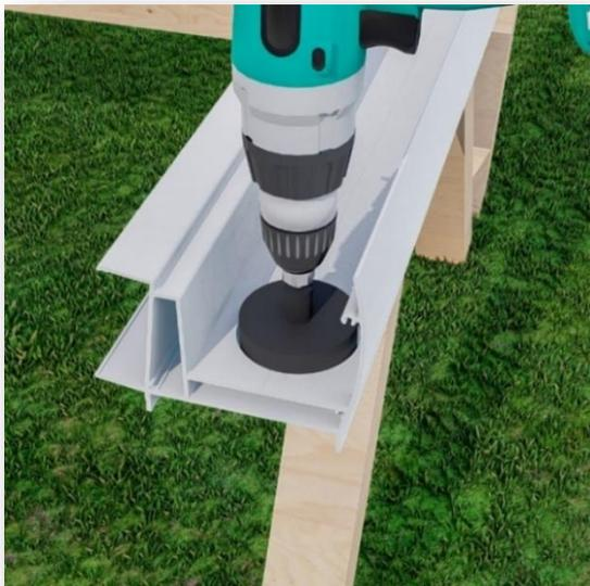
Das Abführen des Wassers innerhalb der Rinne wird durch ein Fallrohr realisiert. Dieses Fallrohr befindet sich nach der Montage innerhalb eines Pfostens. Sie haben die Option, die Position des Wasserablaufs entlang der Rinne auf der rechten oder linken Seite zu bestimmen. Um die Halterung für das Fallrohr zu befestigen, ist es notwendig, ein Loch mit einem Durchmesser von 68mm zu bohren. Der Mittelpunkt dieser Bohrung sollte ungefähr 5-6cm von der äußeren Kante entfernt liegen.
