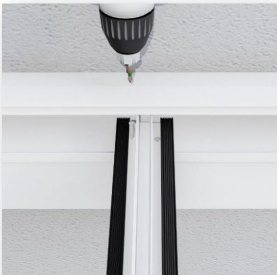
Nachdem die Konstruktion im rechten Winkel steht, können nun alle noch lose hängenden Träger befestigt werden. Wie auch bei den seitlichen Trägern vorgesehen, sollten an der Rinnen- und Hausprofilseite oberhalb jeweils zwei Schrauben angebracht werden.
