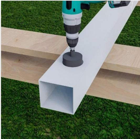
Bei dem Pfosten, an dem das Fallrohr integriert ist, benötigen Sie eine Öffnung für die Umlenkung des Wassers. Die Position und Höhe dieser Öffnung können Sie frei wählen. Normalerweise wird sie etwa 15 cm vom Boden entfernt nach vorne oder zur Seite hin platziert.
