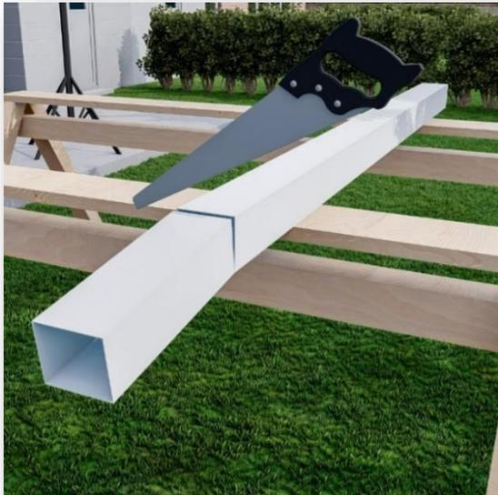
Die Pfosten haben eine Überlänge von ca. 2,5 m. Bitte schneiden Sie den Pfosten auf die zuvor gemessene Länge. Für einen saubereren Schnitt empfiehlt sich die Verwendung einer Kapp Säge.
